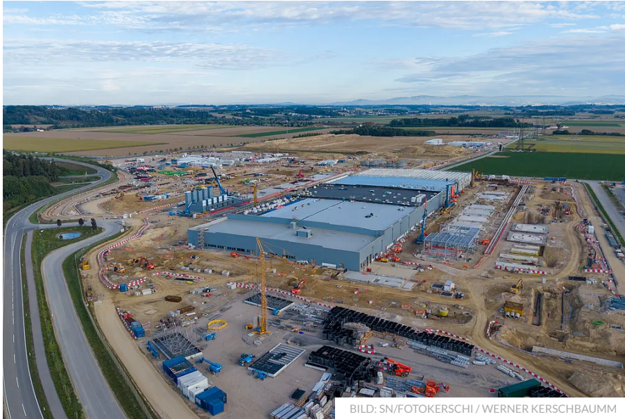
Eine Luftaufnahme zeigt die Baustelle des Google-Rechenzentrums in Kronstorf Ende August.
